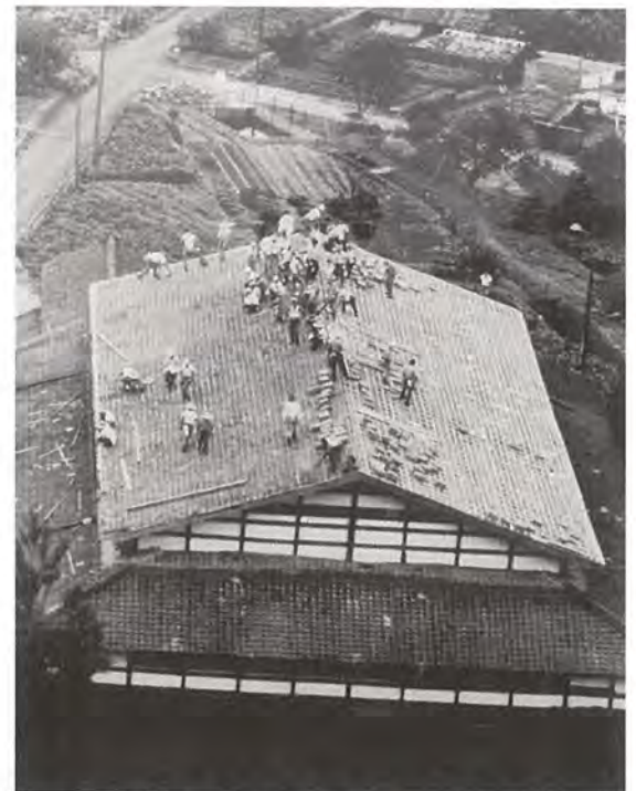
昭和48年の瓦への葺き替えの様子
