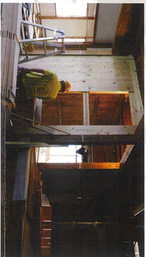
耐力壁による補強
