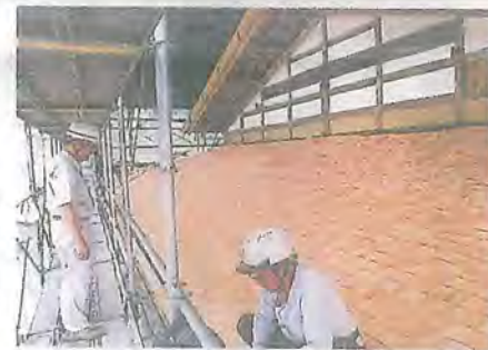
手作業で割いたへぎ板で葺かれた樽葺きの屋根
