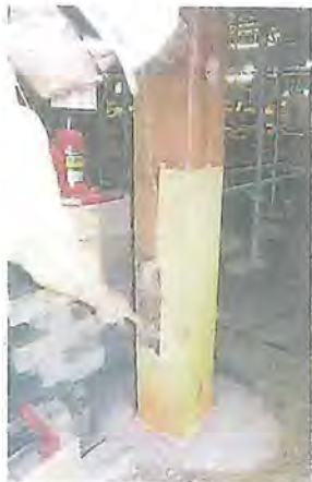
「根接ぎ」で補修され、礎石の上に載る柱=いずれも岐阜県中津川市加子母の明治座で
