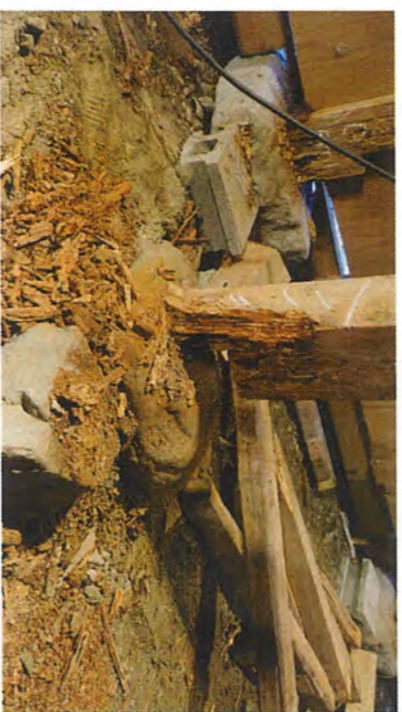
腐朽した柱
