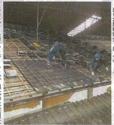
セメント瓦が外され、創建当時の樽葺き屋根が見えた屋根部分＝同、今年3月
