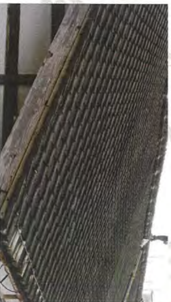
セメント瓦の屋根
