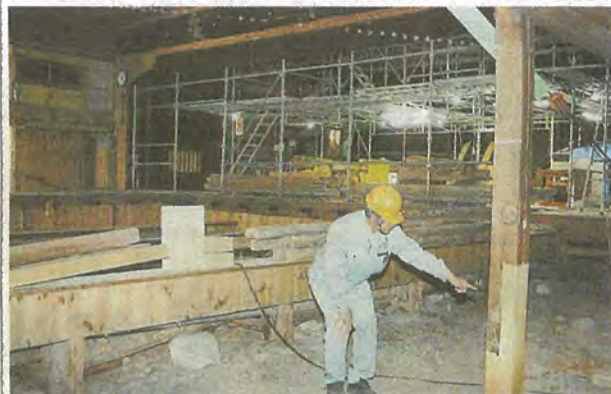
朽ちた柱を新しい木で継ぐなど、改修が進められる建物内＝同
