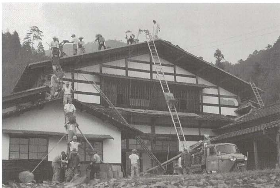
写真 5-1 瓦屋根の葺き替え作業風景
