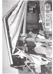
解体後の現場
