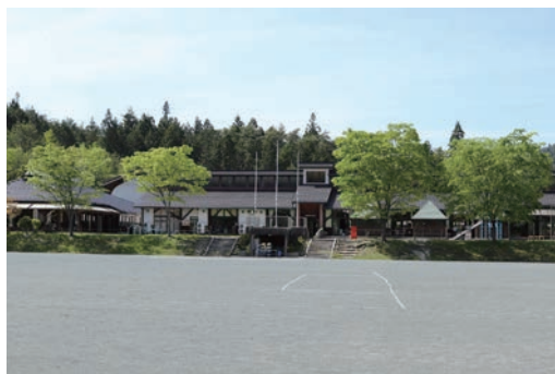
図 4.2-1 中津川市立加子母小学校
