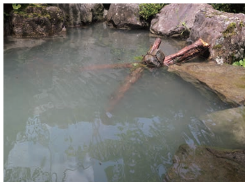
図 4.3-11 調整池エリア③整備後
