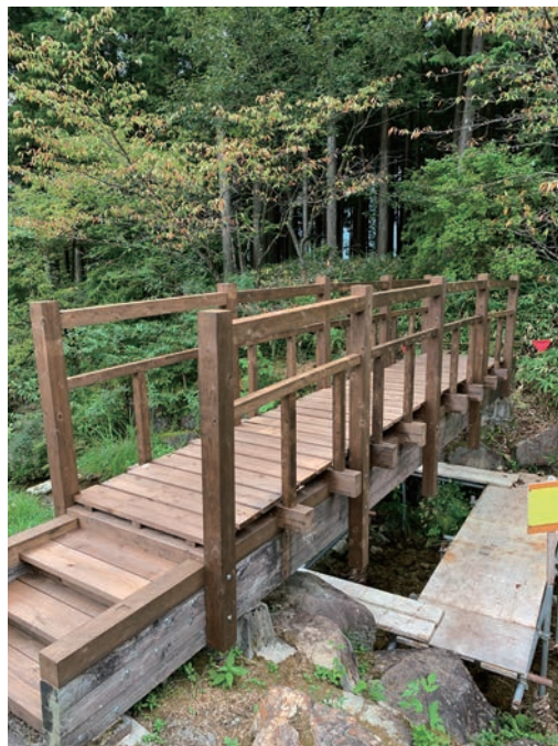
図 3.7-7 立命館大学が改修した橋（2019 年 9 月時点）
