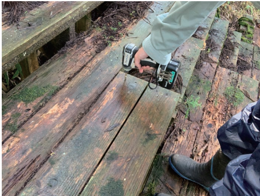
図 4.2-2 階段改修の試み
