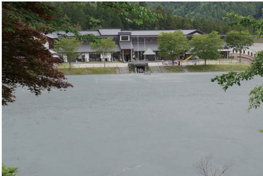
図 3.3-1 中津川市立加子母小学校
