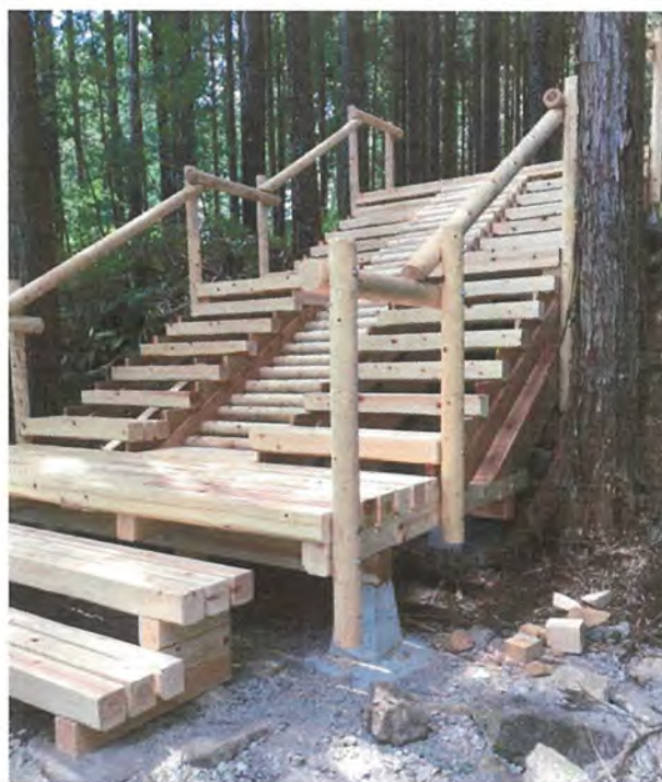
図 4.3-10 大階段の枠組み設置後の里山林エリア
