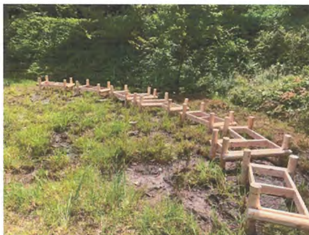
図 4.3-9 木道の枠組み設置後の湿地のビオトープエリア
