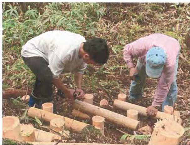
図 4.3-12 土留め階段のビス留め
