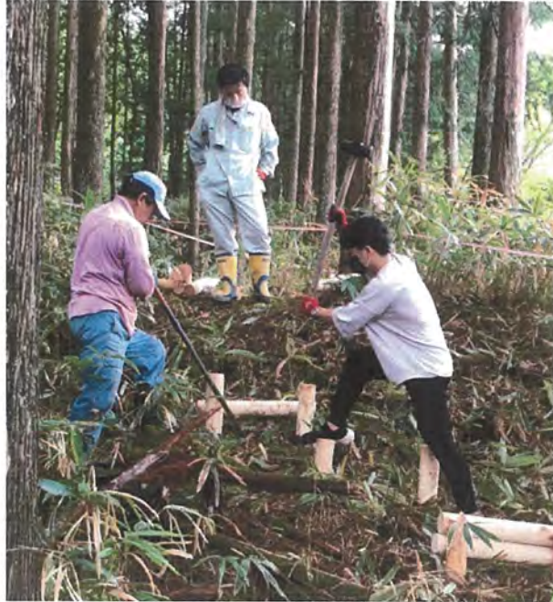
図 4.3-11 土留め階段の杭打ち
