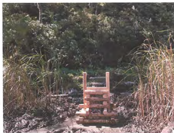
図 4.4-5 石の敷き詰め完了時の橋の土台部分
