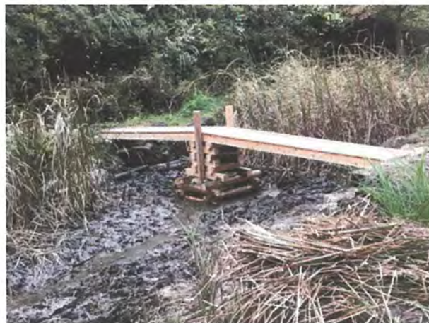
図 4.4-3 設置完了時の池の橋
