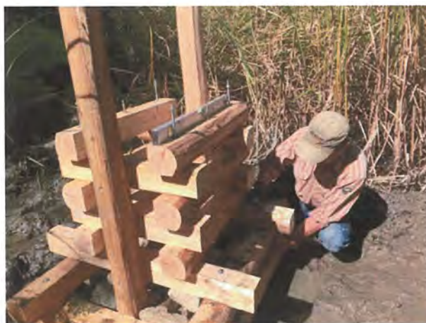
図 4.4-4 土台部分のボルトの締め付け
