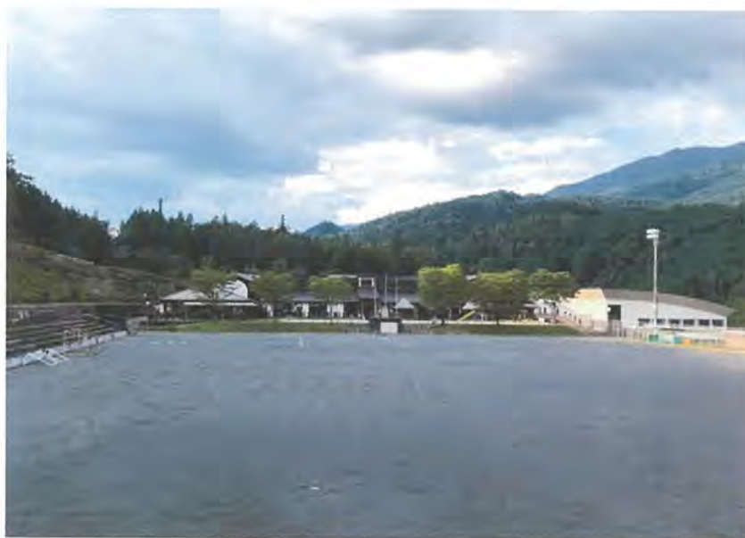
図 2.4-1 中津川市立加子母小学校
